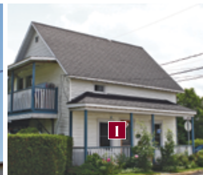
Mur gouttereau sur rue
