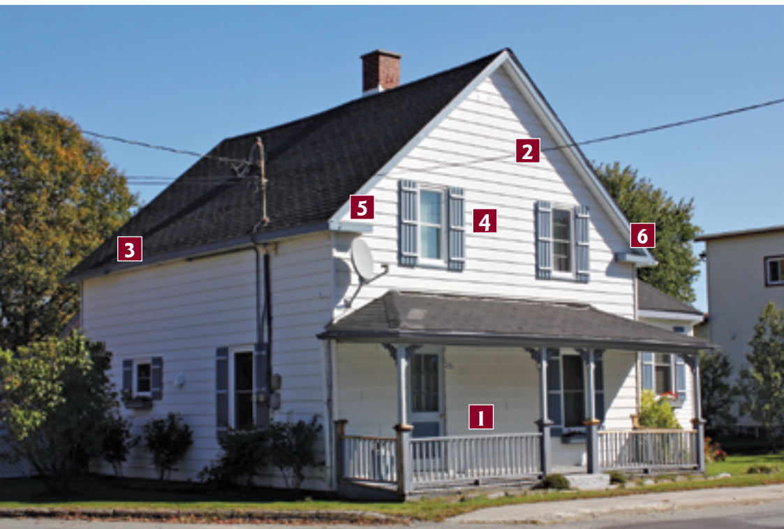
Mur pignon sur rue
