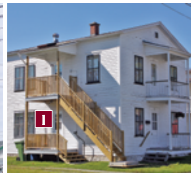
Mur pignon sur rue
