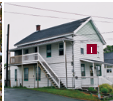
Mur pignon sur rue
