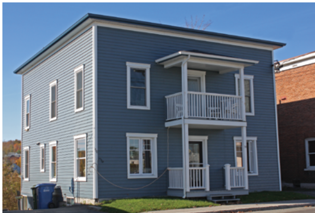
Exemple d'édifice où une seule couleur est utilisée sur les murs et une couleur secondaire pour les menuiseries de contour ( chambranles et planches cornières ).
