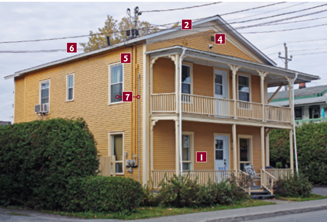
Mur pignon sur rue
