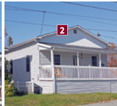
Toit à deux versants
