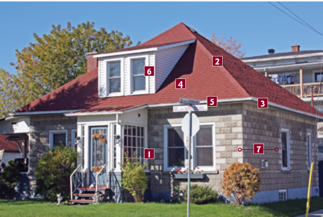
Toit à quatre versants
