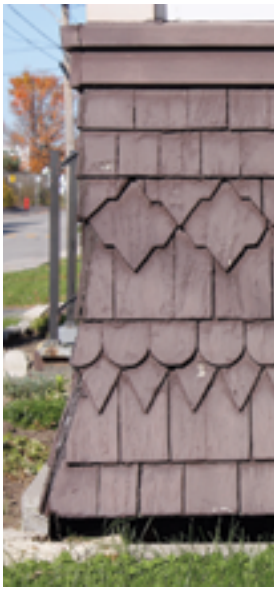
Le bardeau de bois découpé : un revêtement aussi durable qu'esthétique que l'on a tout intérêt à préserver.
