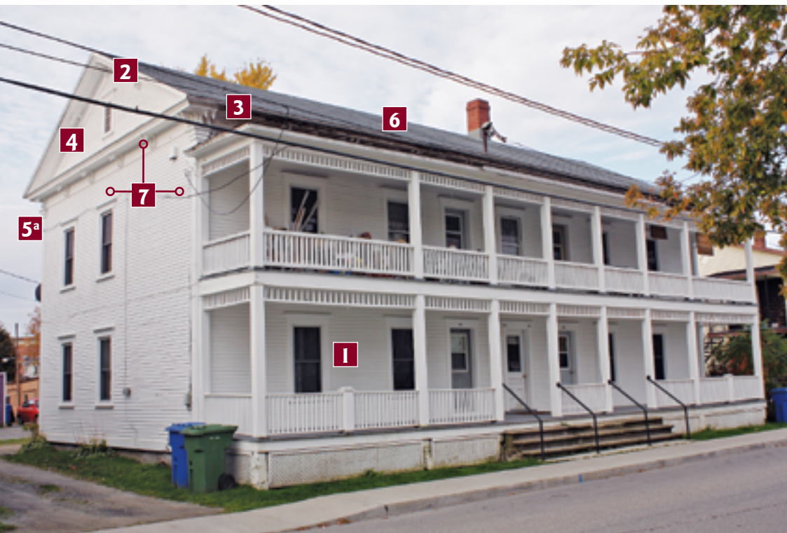
Mur gouttereau sur rue
