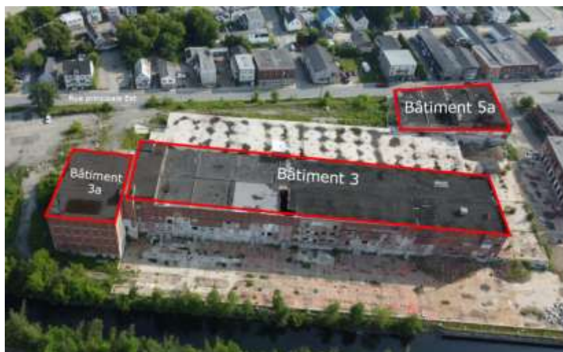
160, rue Principale Est - Bâtiments visés par l'autorisation de démolition.
