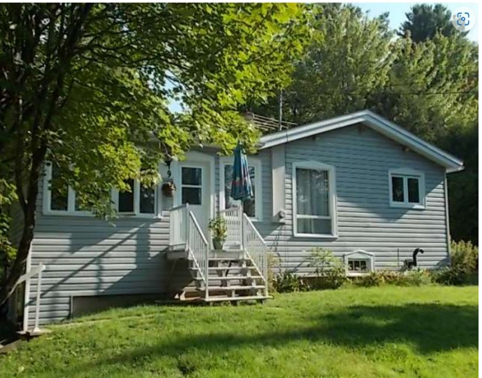
9, rue des Berges
