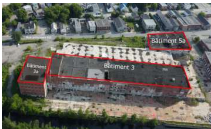
160, rue Principale Est - Bâtiments visés par la démolition.
