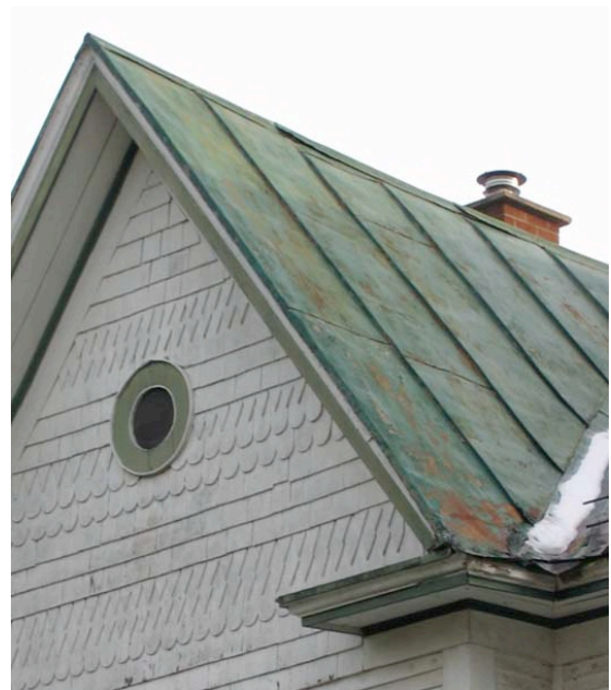
Revêtement de tôle pincée sur un édifice au toit à deux versants droits. Rue du Collège. IMG_3116.jpg
