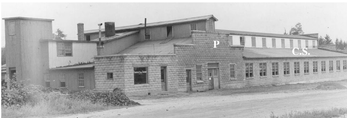
Fonderie de Magog. À l'origine, au-dessus de la porte principale, se dressait un mur parapet (P) ; le corps secondaire (C.S.), conservé aujourd'hui, était doté d'une section surélevée destinée à accroître l'éclairage, typique des bâtiments industriels. Collection Société d'histoire de Magog. Fonderie magog.jpg
