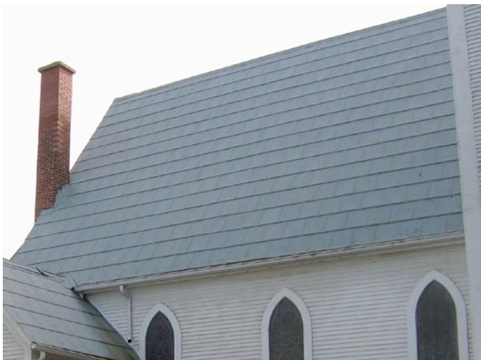
Revêtement de tôle en plaques sur un toit à deux versants droits. Rue des Pins. IMG_9698. copie.jpg
