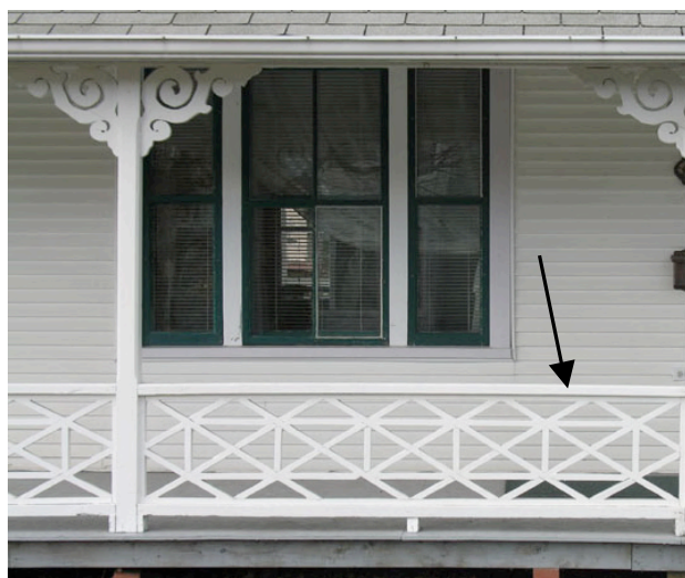
Garde-corps de type stick style (ou style « bâton »), ainsi appelé à cause du rappel de pièces de bois de diverses longueurs. Rue Merry Nord. IMG_9645.jpg
