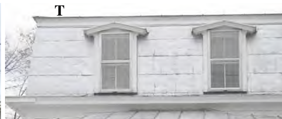
Revêtement de tôle en plaques sur le brisis d'une toiture mansardée. Le terrasson (T) est recouvert de tôle pincée. Rue Merry Nord. IMG_0404.jpg
