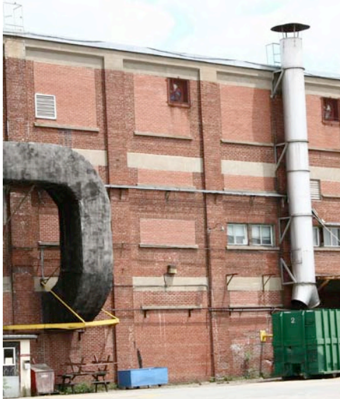
Pilastres (éléments verticaux en saillie), bâtiment n° 17 de l'ancienne usine Dominion Textile (C.S. Brooks). 20070705IMG_1803 copie.jpg
