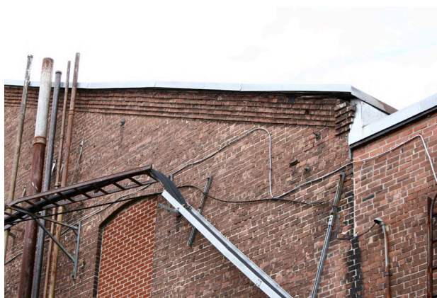
Jeux de brique au sommet du mur, bâtiment n° 18 de l'ancienne usine Dominion Textile (C.S. Brooks). 20070705IMG_1790.jpg
