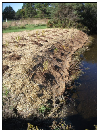
Image montrant une stabilisation végétale de la rive à l'aide d'un matelas de coco pour couvrir la surface mise à nu et montrant les plantations réalisées.
