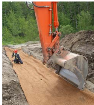
Matelas de paillis installé suite à un ensemençement (Image Ville de Magog)
