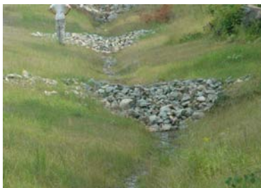
Bermes de rétention (Image Aqua-Berge)
