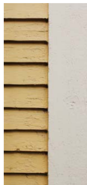
La planche cornière, l'une des menuiseries de contour typique des maisons anciennes.
