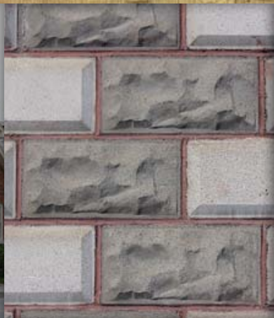
La maçonnerie de béton, un exemple de matériau fréquent à Magog; celui-ci présente un excellent état de conservation.
